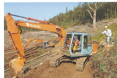
作業道作設研修
