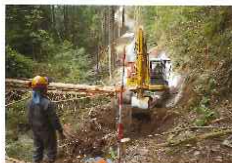
作業道作設研修
